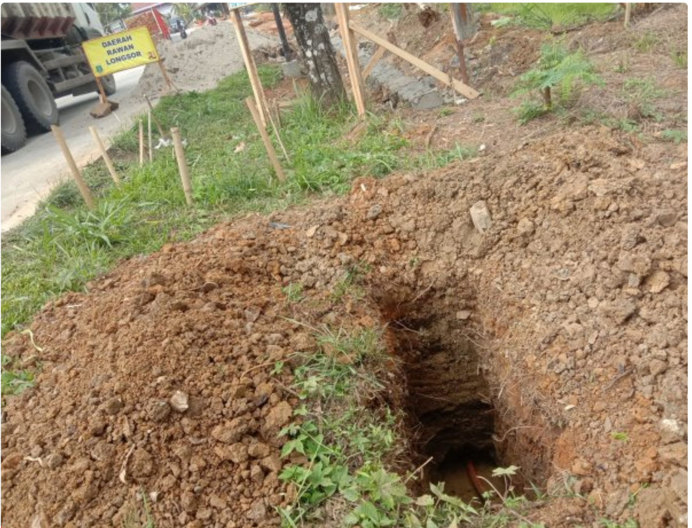
Salah satu galian fiber optic di jalan Malingping-Saketi
